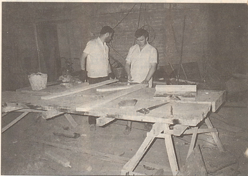
Prace restauracyjne w górnym kościele
